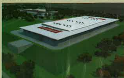
Data Center do Banco Santander Campinas SP
